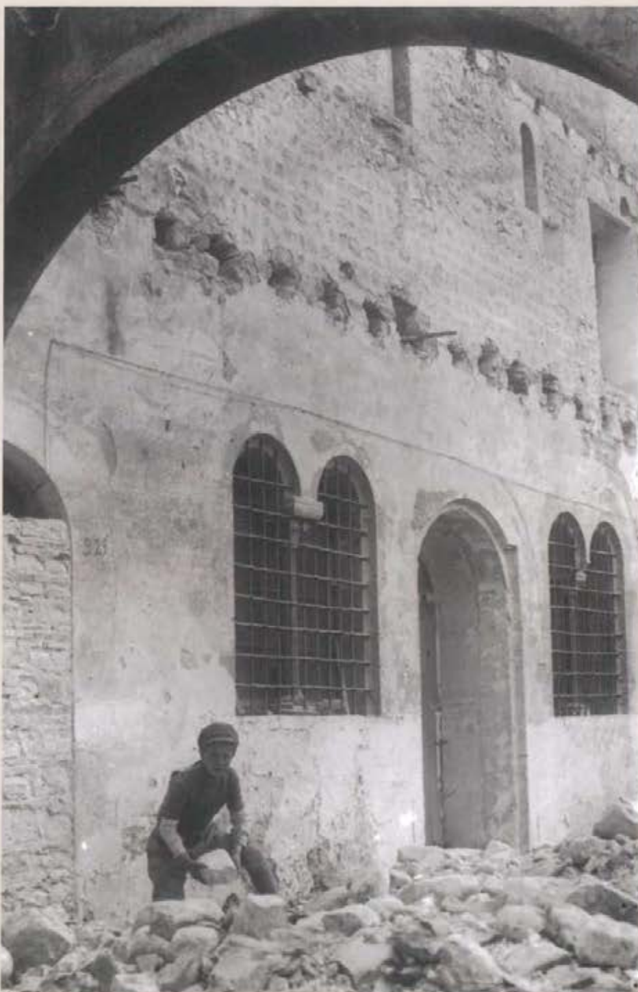
Abbazia di Follina - Follina. Restauri degli anni 1919-21. L'ambulacro del Chiostro all'altezza dell'ingresso della sala capitolare in una fase dei restauri. Archivio Ballarin
